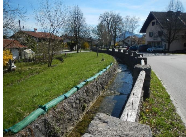
Abbildung 1.4: Ausgebauter Abflussquerschnitts des Mühlstätter Grabens 2 (aquasoli 2022a)
