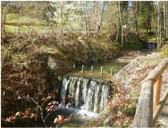
Abbildung 4.1: Absturzbauwerk mit Schwemmholtzrückhalt (aquasoli 2022)
