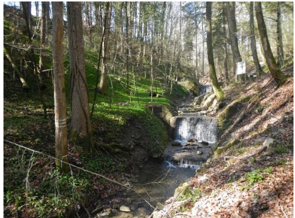
Abbildung 4.2: Sohlstabilisierende Querbauwerke im Mittellauf des Mühlstätter Grabens (aquasoli 2022)
