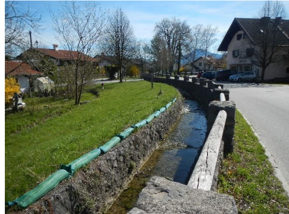
Abbildung 1.4: Ausgebauter Abflussquerschnitts des Mühlstätter Grabens 2 (aquasoli 2022a)
