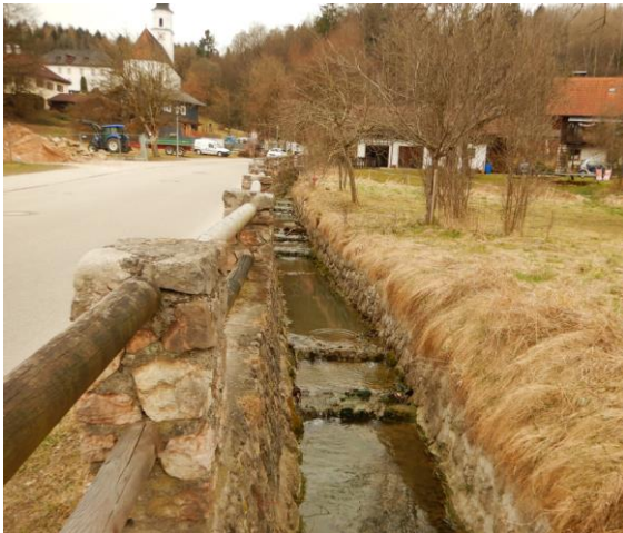
Abbildung 7.4: Sohlschwellen Mühlstätter Graben (aquasoli 2022)
