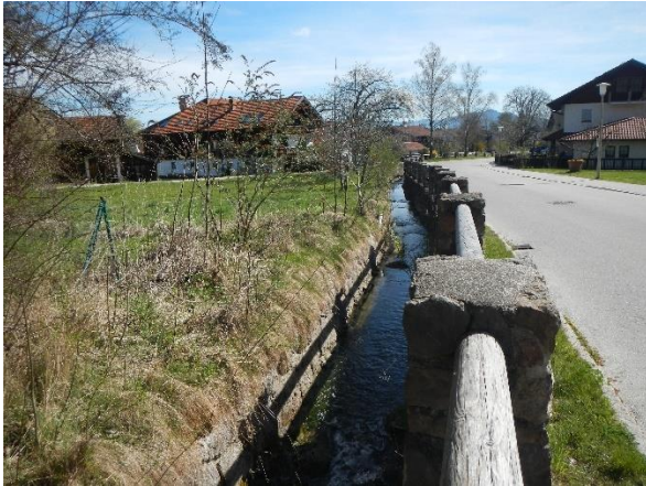
Abbildung 1.3: Ausgebauter Abflussquerschnitts des Mühlstätter Grabens 1 (aquasoli 2022a)
