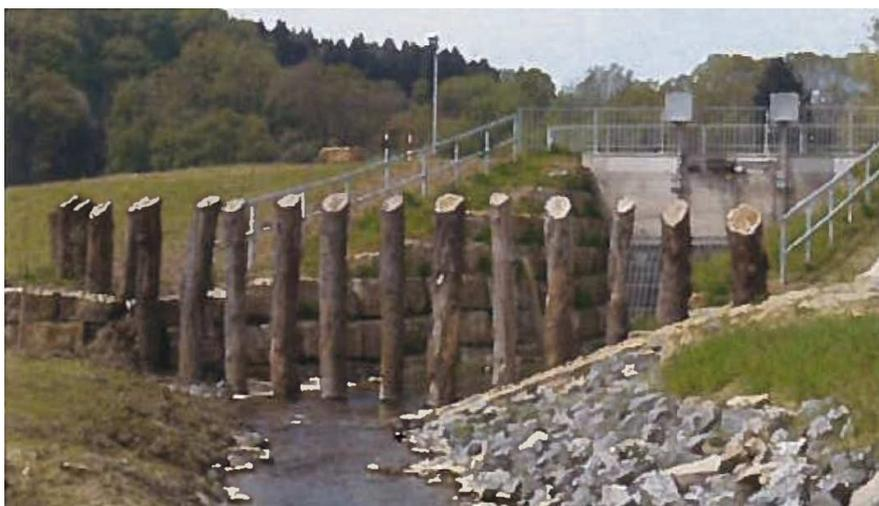
Aus optischen und Kostengründen wird diese Ausführung nicht umgesetzt. Der räumliche Rechen wird so ausgeführt wie der bereits vorhandene Rechen am Maibaum in der Halmsrieder Straße. Daraus gibt sich, dass im Einstaufall eine Bedienbarkeit des Rechens nicht möglich ist. Auf den Grobrechen kann aufgrund eines geringen Baumbestandes im Einzugsbereich des HRB 3 verzichtet werden.
