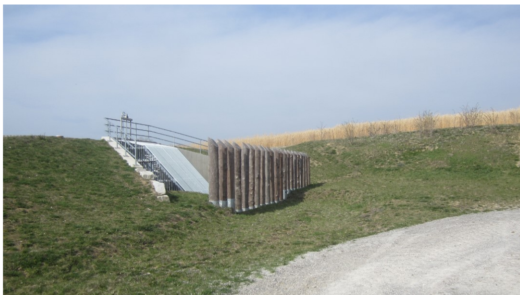
Bild eines vergleichbaren Bauwerks von der „Wasserseite“ Pier mit Grobrechen und Weg
