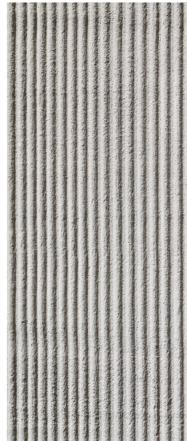
Fassade: Kammzugputz Farbe Grau-Beige, Fenster-Faschen mit Glattputz
