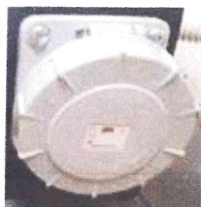
Steckdose für Einspeisung (1 h Stellung)
