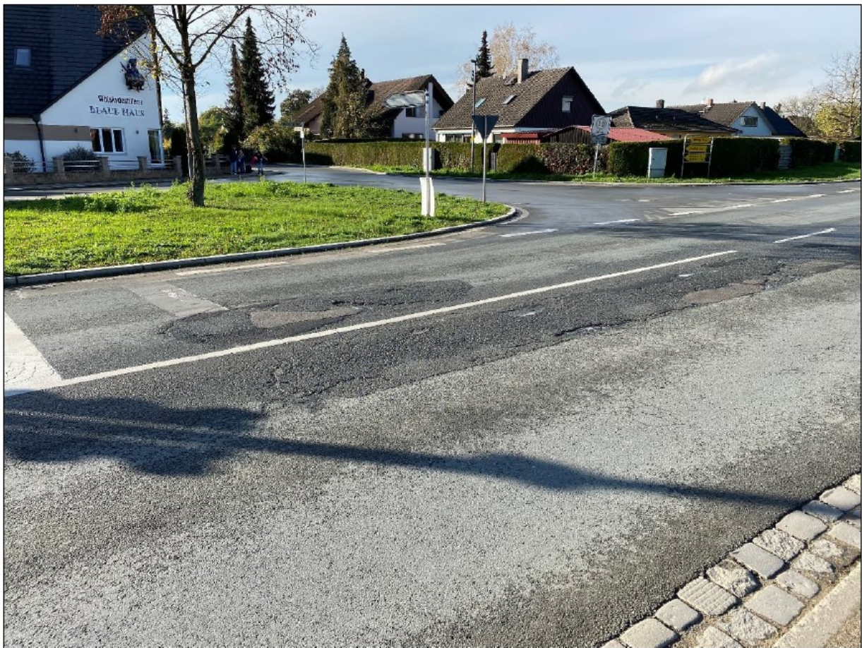
Abbildung 6: Fahrbahnschäden im Bereich der bestehenden Ortsdurchfahrt von Neuses a.d.Regnitz
