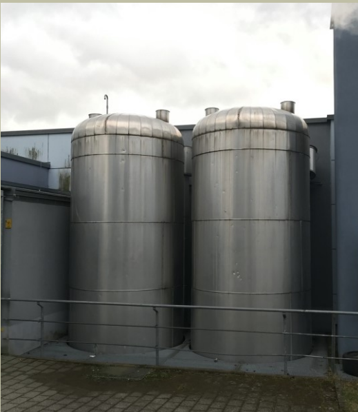
35 Jahre alte Pufferspeicher im Außenbereich
