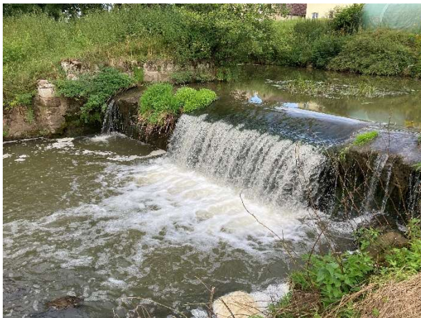
Abbildung 1: Ist-Situation 2021 im Ortsbereich von Bruck: Absturz an einem Ausleitungsbauwerk beschränkt die lineare Durchgängigkeit für zahlreiche aquatische Organismen. Bei einem Höhenunterschied von etwa 1,30 Metern wird hier die Ausbreitung selbst von leistungsstarken Fischarten verhindert. (Foto: WWA Ansbach)
