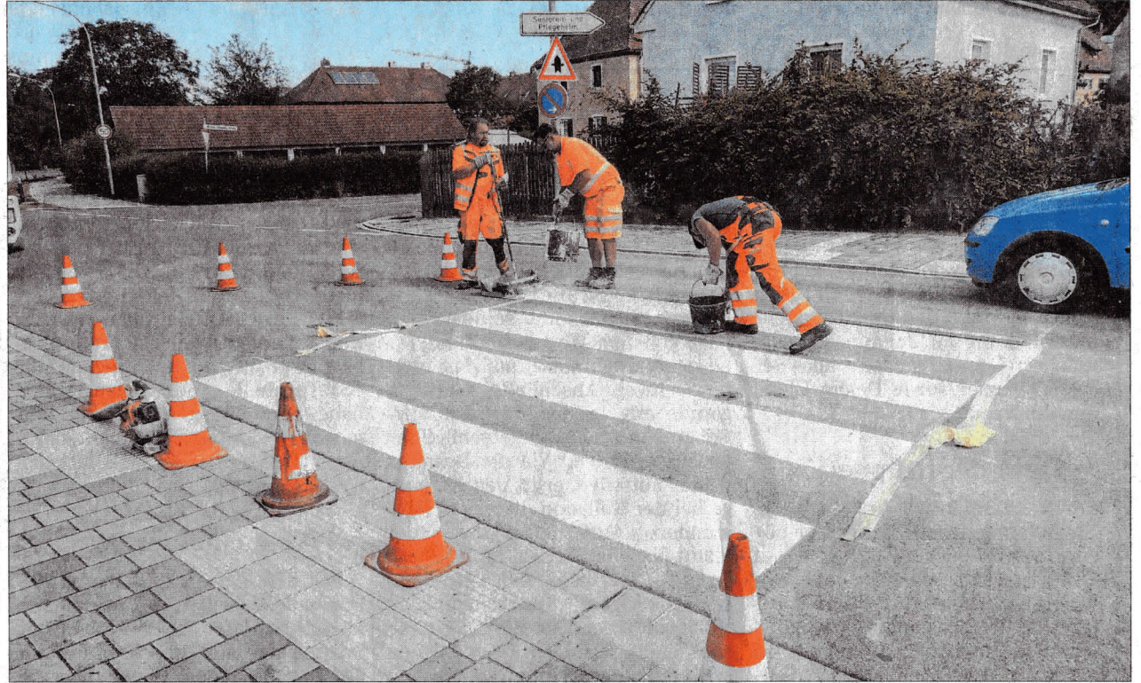
Einen Zebrastreifen haben Arbeiter einer Fachfirma gestern in den Asphalt der Rothenburger Straße unweit des Kreisseniorheims, auf das das weiße Schild im Hintergrund hinweist, eingefräst. Foto: Peter Zumach
