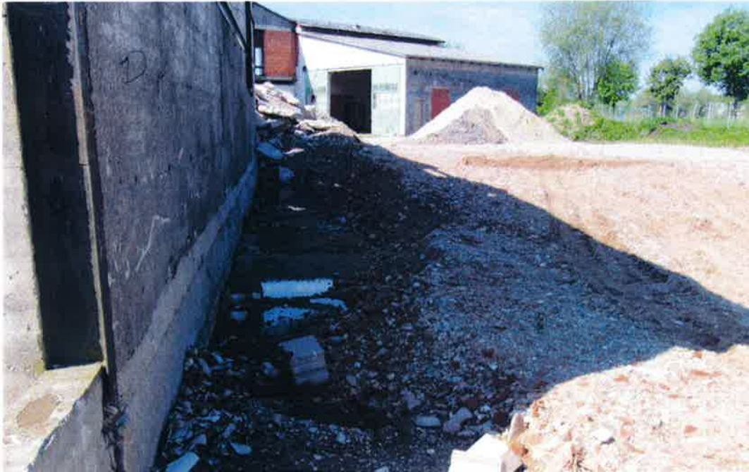
Abbildung 1: Bereich mit Verfüllung von gebrochenem Bauschutt und Kies auf Fl.-Nr. 1179.
