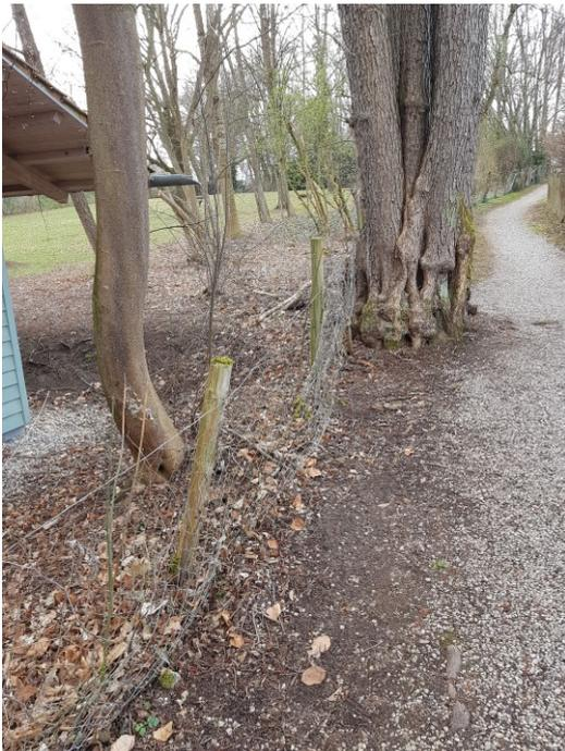
An der Straßenseite müssten die Bundstangen und die einzelnen Staketen auf der ganzen Länge ausgewechselt werden. Die Befestigungspfosten und Randsteine können vermutlich verbleiben.
