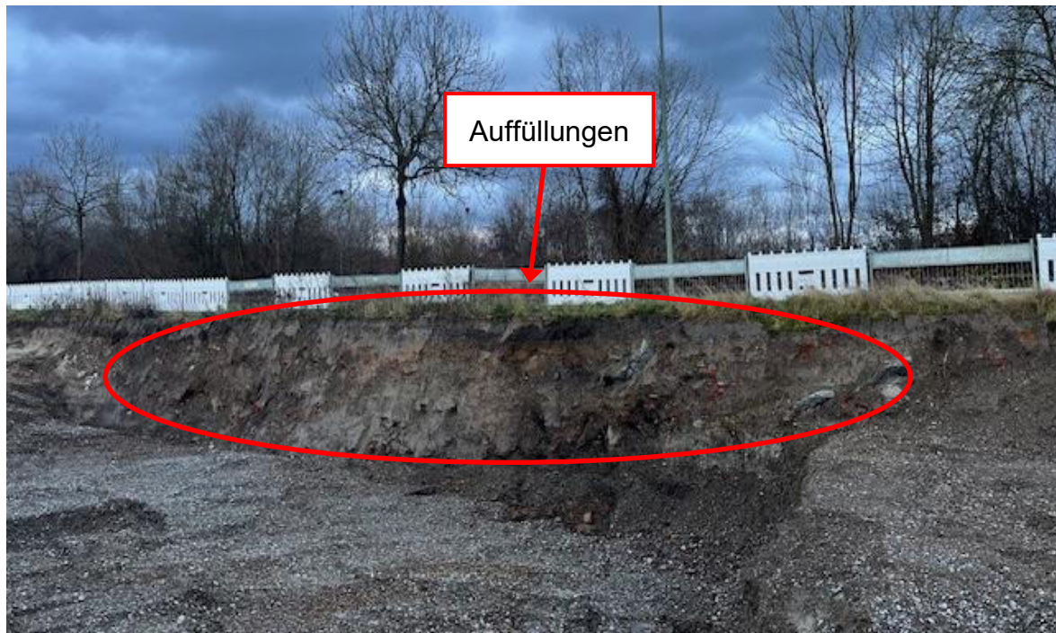
Bild 2: Böschung Sanierungsgrube zum Rad-/Fußweg vor Sicherung
