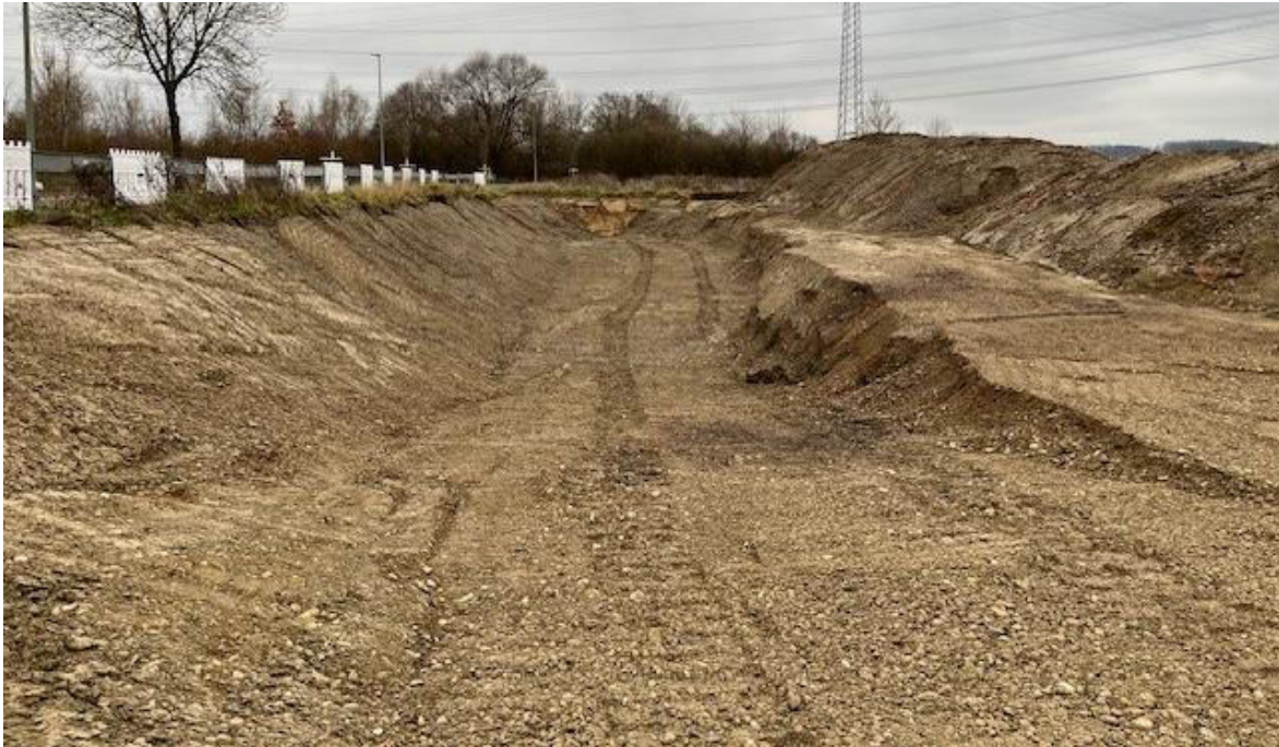
Bild 4: Sanierungsgrube mit Böschungssicherung Rad-/Fußweg
